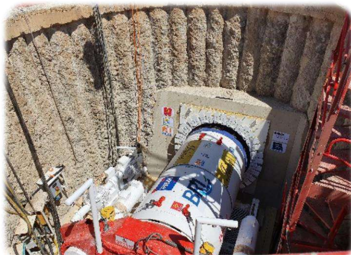
Tunnelier sous l'Orb (Ø 1600 mm) : point d'entrée ...
