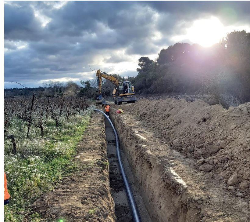
Réseau Nord-Est Béziers - phase 2
