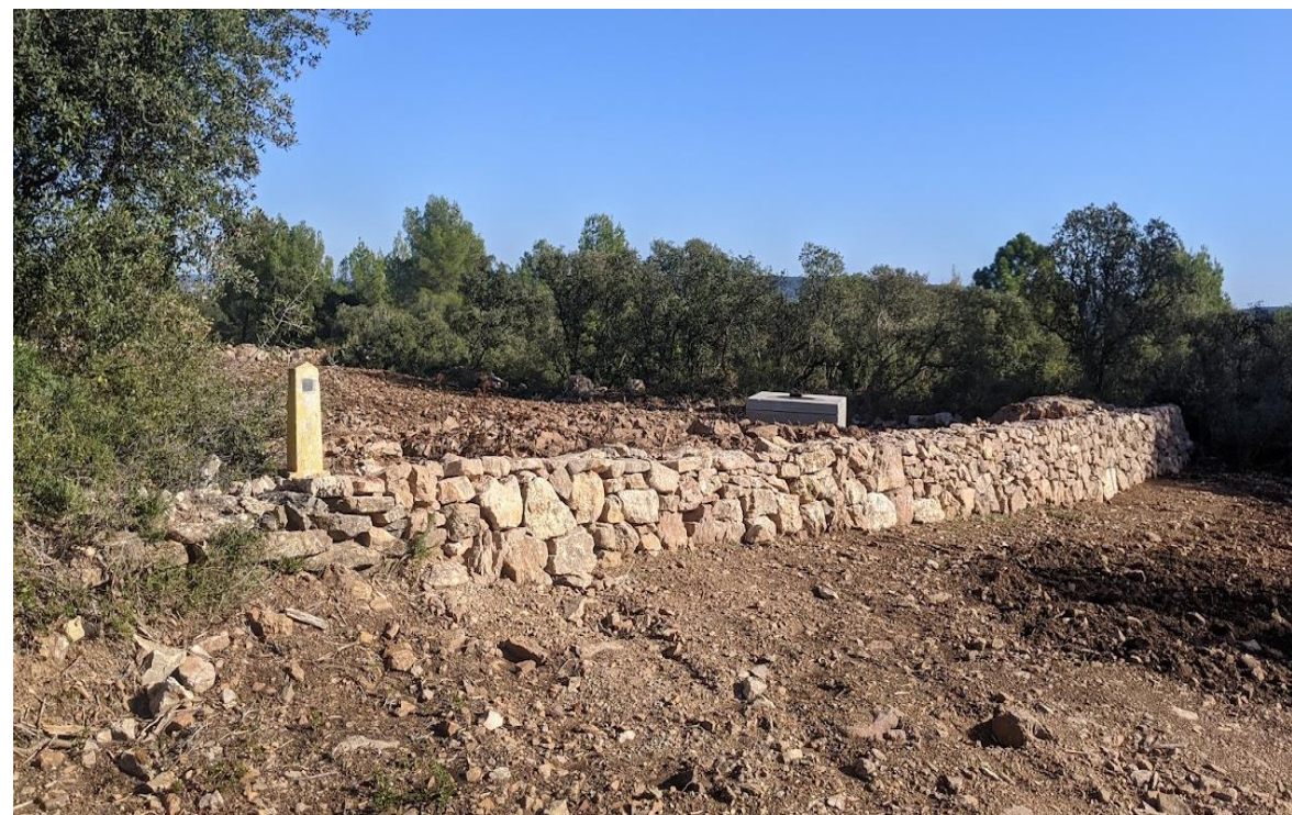
Mur achevé avant chargement de la face arrière
