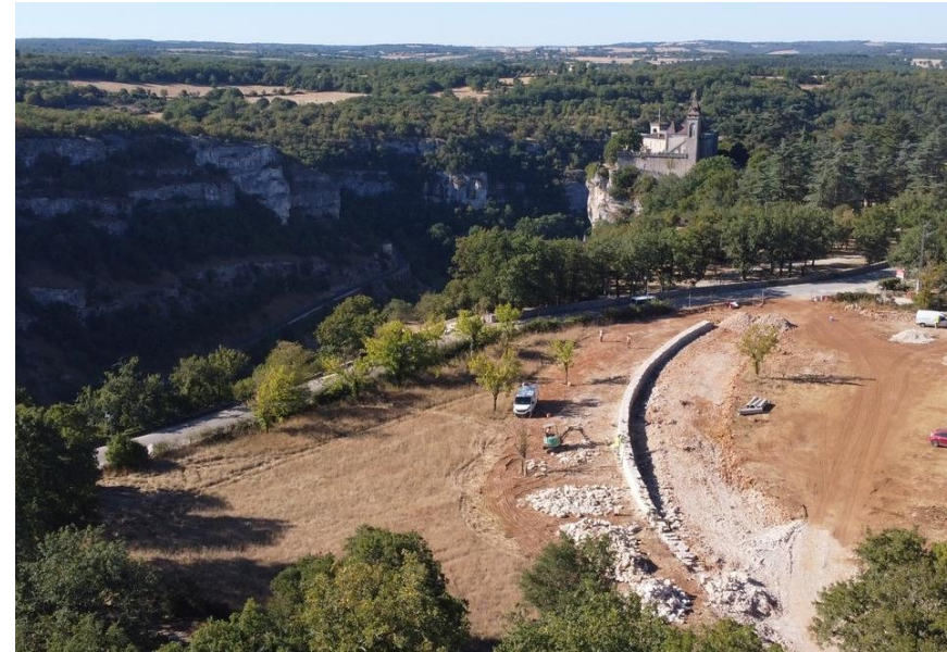
Route départementale en construction, Rocamadour (Lot) ; photo G. Viossanges
