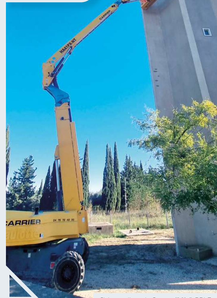
Château d'eau de Gonnet (30) © BRLE
