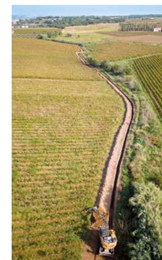
Travaux sur l'extension Collines des Costières © Lionel Ruhier
