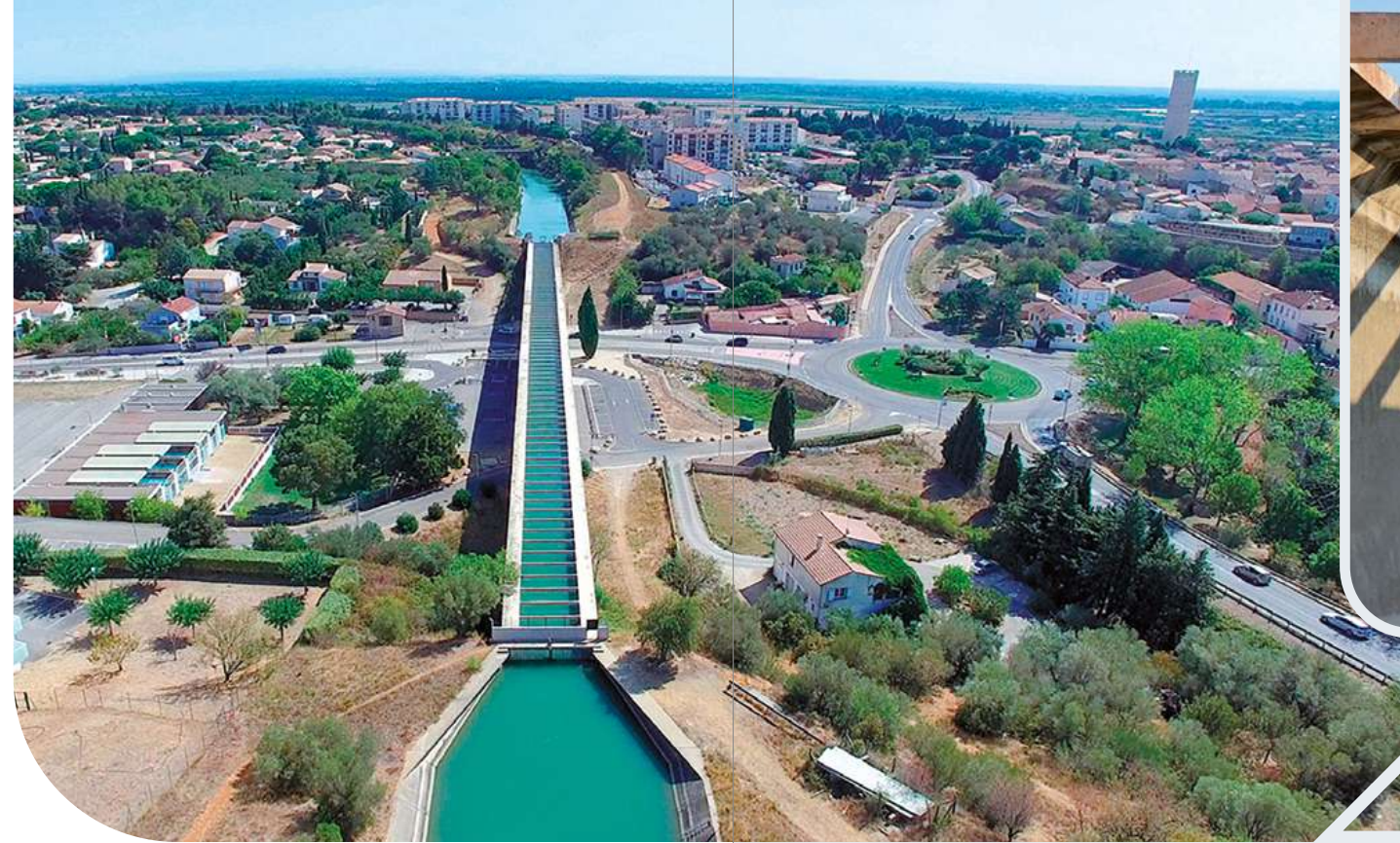
Pont-canal de Saint-Gilles © Dronestudio
