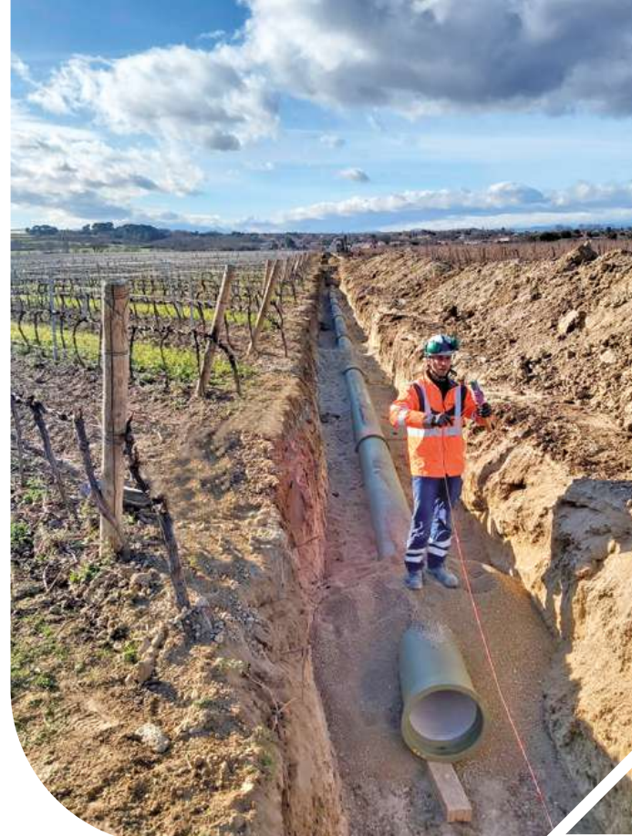
Chantier du périmètre Nord-Est Béziers © BRLI
